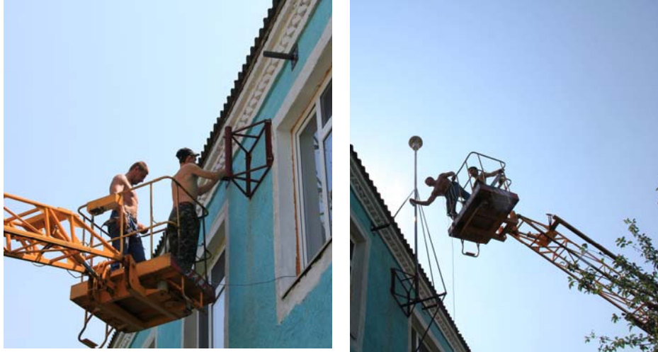
Рис. 2. Монтування конструкції опори
