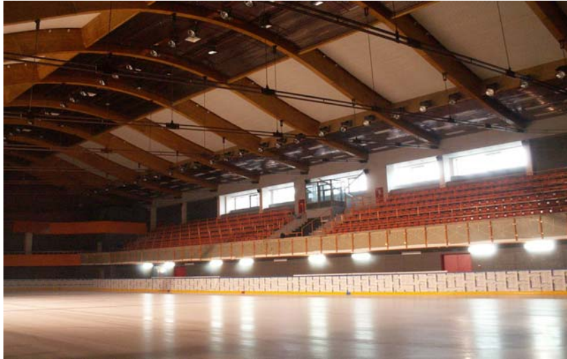
Рис. 3. Покриття будівлі льодової арени у м. Пінську
