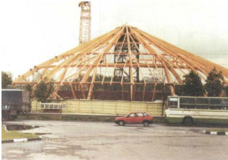
Рис. 1. Будівництво складу протижеледних реагентів у м. Москва
