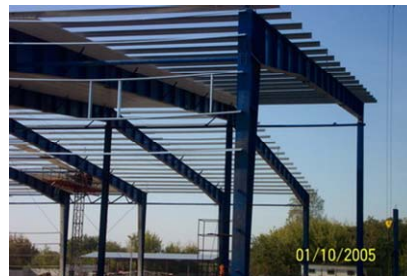
Рис. 3. Каркаси зі зварних двотаврів змінного перерізу: а) монтаж сталевих конструкцій рамного каркаса; б) будівництво логістичного центру у м. Обухів Київської обл.
