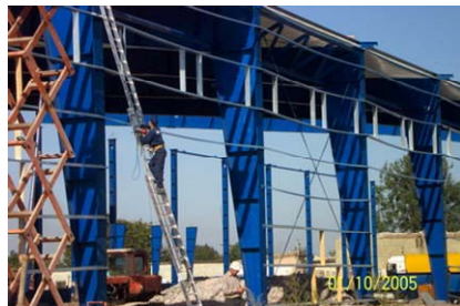
Рис. 3. Каркаси зі зварних двотаврів змінного перерізу: а) монтаж сталевих конструкцій рамного каркаса; б) будівництво логістичного центру у м. Обухів Київської обл.
